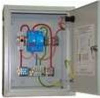
ЩЗИП® с установленным УЗИП класса I+II для защиты однофазной электроустановки переменного тока, кабельная линия питания, система заземления типа TN-S,  $U_N = 230$  В, до  $I_N = 32$  А. Ввод-вывод снизу. Подключение в разрыв питающей сети. Световая сигнализация о выходе из строя УЗИП на дверце шкафа. Автоматический выключатель на 32 А предназначен для защиты всей электроустановки от токов короткого замыкания. 400\*300\*150 мм. IP30. УХЛ4.
