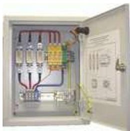
ЩЗИП® с установленным УЗИП класса II для защиты трехфазной электроустановки переменного тока, система заземления типа TN-S,  $U_N = 380$  В,  $I_N = 160$  А. Ввод снизу. Подключение параллельно защищаемой нагрузке. Для защиты УЗИП от тока короткого замыкания установлены предохранители 160 А gG. Световая сигнализация о выходе из строя УЗИП на дверце шкафа. 400\*300\*150 мм. IP30. УХЛ4.
