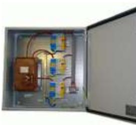
ЩЗИП® с установленными УЗИП класса I и II для защиты трехфазной электроустановки переменного тока, воздушная линия питания, система заземления типа TN-C,  $U_N = 380$  В,  $I_N = 63$  А. Ввод-вывод снизу. Подключение в разрыв линии питания. Автоматический выключатель на 63 А предназначен для защиты всей электроустановки от токов короткого замыкания. По техническому заданию заказчика выбран автоматический выключатель с возможностью опечатывания Энергосбытом. 500\*500\*250 мм. IP65. УХЛ1
