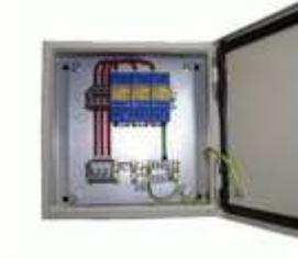
ЩЗИП® с установленными УЗИП класса I для защиты трехфазной электроустановки переменного тока, воздушная линия питания, система заземления типа TN-C,  $U_N = 380$  В,  $I_N =$  до 315 А. Ввод снизу. Подключение параллельно защищаемой нагрузке. 300\*300\*150 мм. IP55. УХЛ3.
