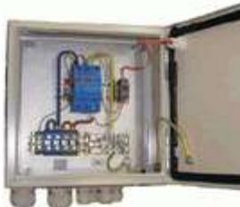
ЩЗИП® с установленным УЗИП класса I+II для защиты электроустановки постоянного тока, кабельная линия питания, система заземления типа TN-S,  $U_N = 48$  В DC,  $I_N$  до 315 А. Ввод снизу. Подключение параллельно защищаемой нагрузке. 300\*300\*150 мм. IP54. УХЛЗ. По требованию заказчика установлен дополнительный комплект клемм.
