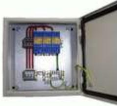
ЩЗИП® с установленными УЗИП класса I для защиты трехфазной электроустановки переменного тока, воздушная линия питания, система заземления типа TN-C,  $U_N = 380$  В,  $I_N =$  до 315 А. Ввод снизу. Подключение параллельно защищаемой нагрузке. 300\*300\*150 мм. IP55. УХЛ3.
