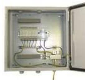
ЩЗИП®-ТМ для защиты 6-ти двухпроводных линий передачи данных, управления, контроля и измерения с установленным регистратором грозовых и коммутационных импульсных токов СИТЭ-100К-1. Подключение проводников защищаемых линий на клеммы УЗИП. Ввод-вывод снизу. 300\*300\*150 мм. IP55. УХЛ3.
