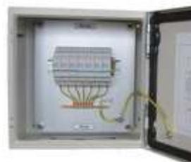
ЩЗИП®-ТМ для защиты 10-ти двухпроводных линий передачи данных, управления, контроля и измерения. Подключение проводников защищаемых линий на дополнительные клеммы. Ввод снизу-вывод сверху. 300\*300\*150 мм. IP55. УХЛ3.
