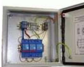
ЩЗИП® с установленным УЗИП класса I+II для защиты электроустановки постоянного тока, кабельная линия питания, система заземления типа TN-S,  $U_N = 220 \text{ В DC}$ ,  $I_N$  до 315 А. Ввод сверху. Подключение параллельно защищаемой нагрузке. 300\*300\*150 мм. IP54. УХЛ3.
